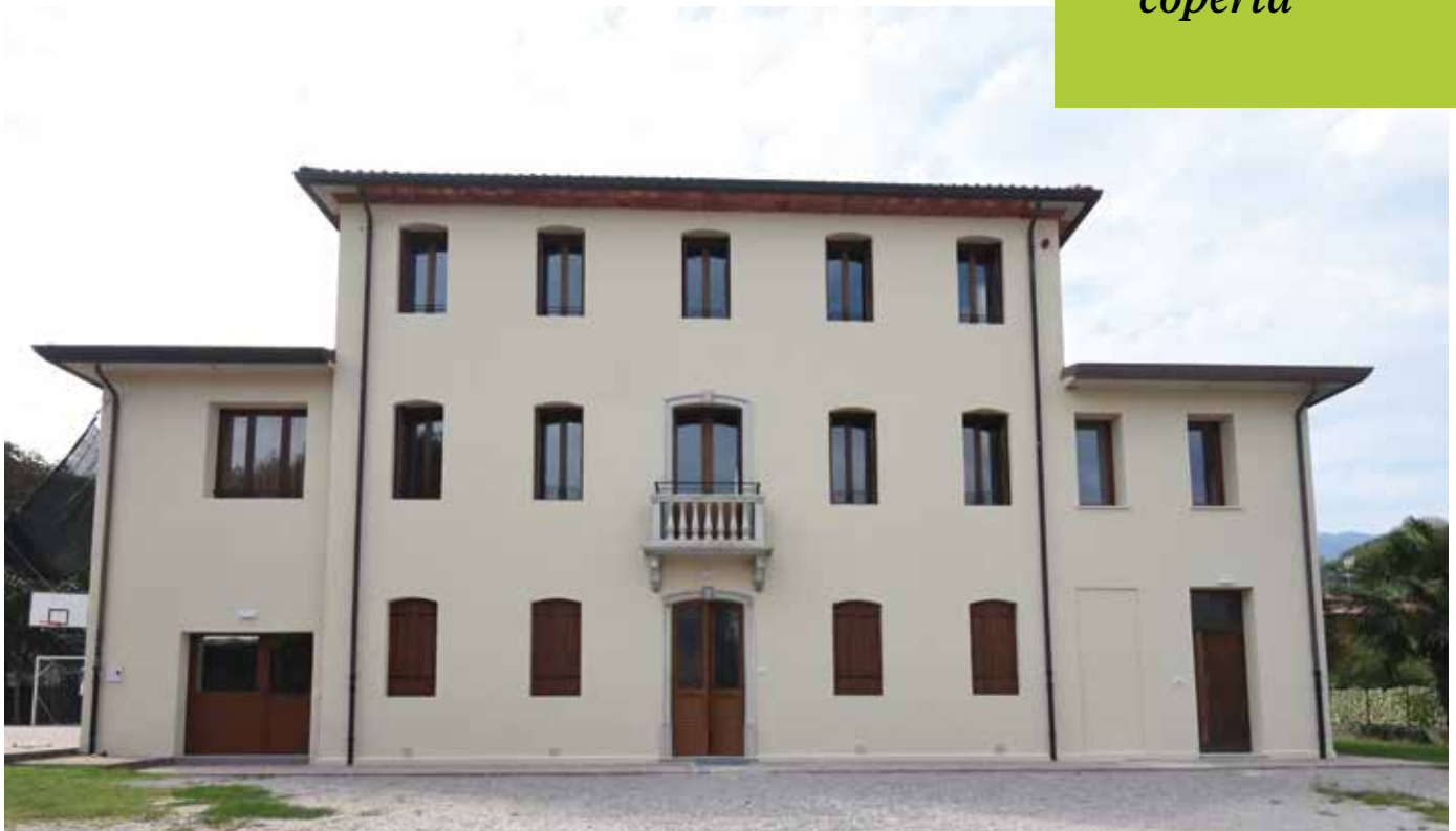
Foto Terna Costruzioni srl
